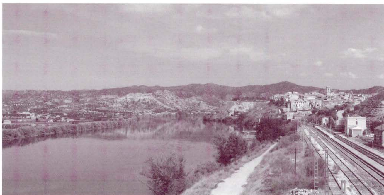
Imatge de Ribarroja d'Ebre, amb el riu Ebre en primer pla, on Iberdrola té previst construir una central de 800 MW. Foto: Marta Casas.
