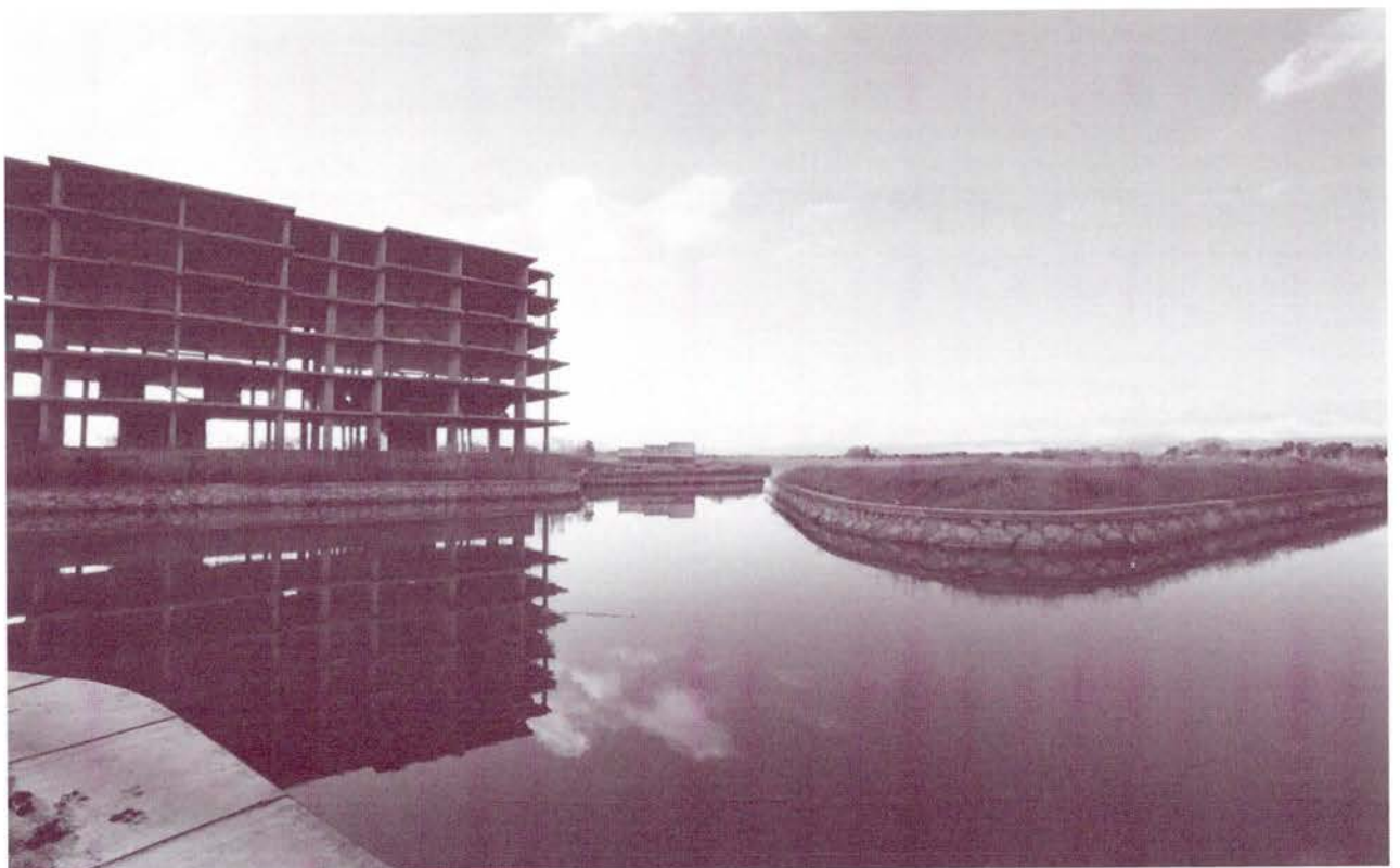
El Departament de Política Territorial i Obres Públiques va adquirir una parcel·la de Fluvianàutic per procedir a l'enderroc de l'edifici a mig construir. Foto: Àlex Tarroja
