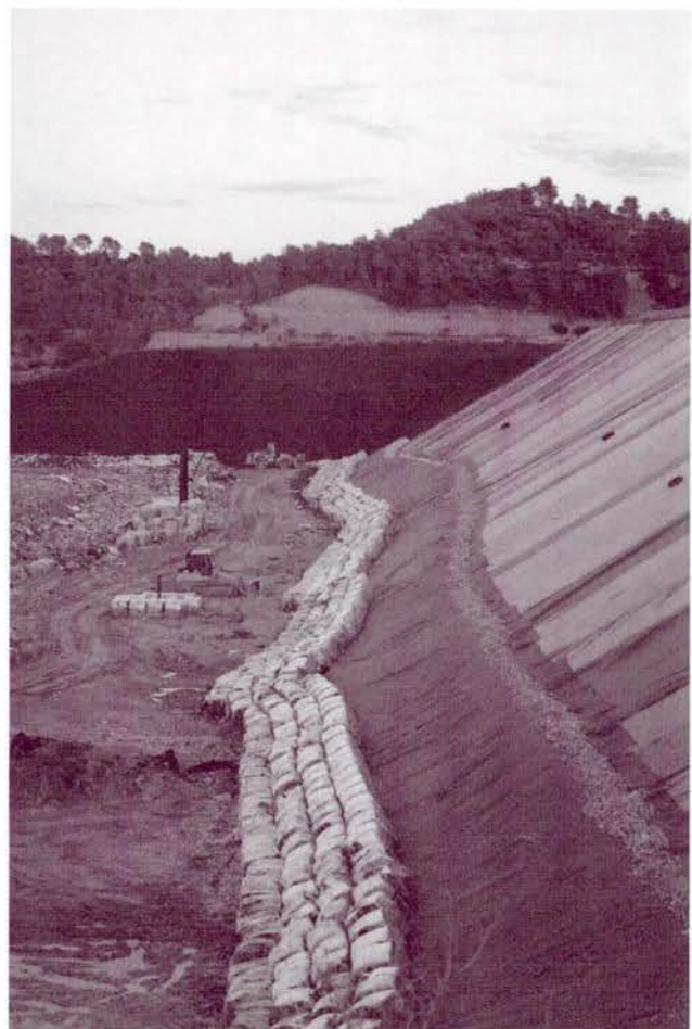
Després que els informes encarregats van concloure que no afectava l'aqüífer, l'abocador va entrar en funcionament al mes d'octubre. Foto: Marta Casas
